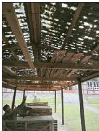
Vor den Arbeiten an der Außenanlage
